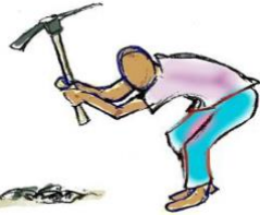
1. Chinta shimo la urefu wa 18 inch na urefu wa futi 2 kutoka shimo la kwanza na mwisho
