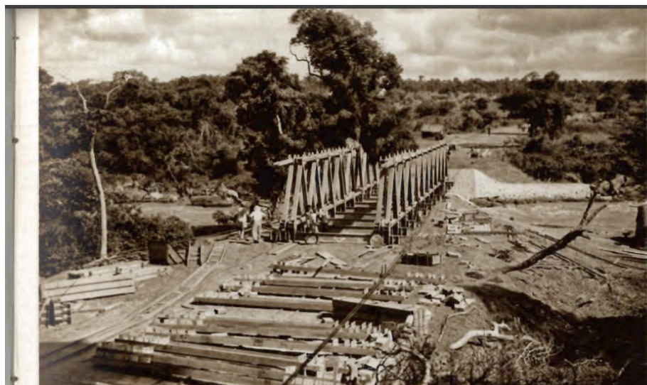
Ouverture d'une route et placement de pont métallique par la «Diamang».
